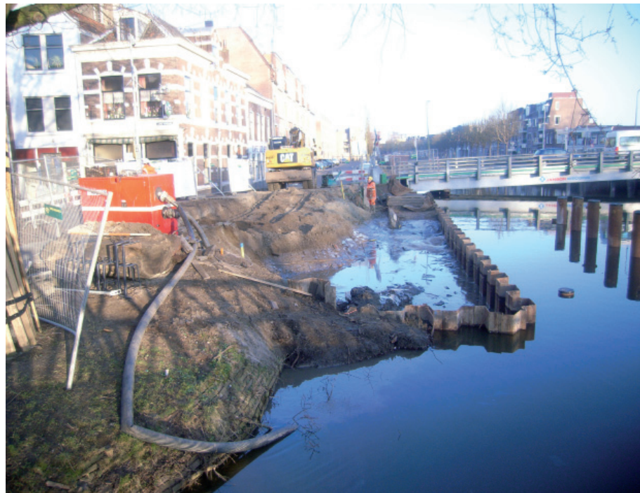
Afb. 3.7 Het plangebied na amovatie van het oude bruggehoofd.
