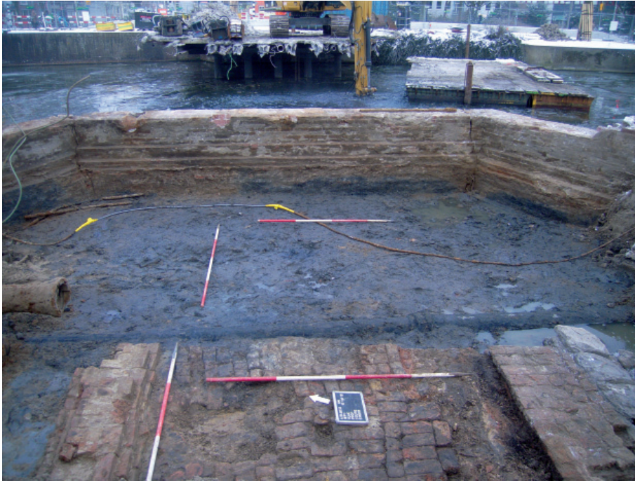
Afb. 3.5 Overzicht van het bruggehoofd vanuit het zuidwesten.
